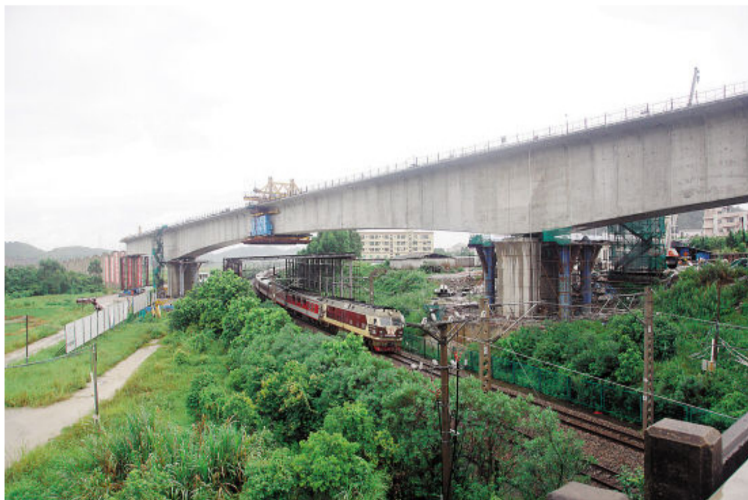
全线最大跨既有线无拱连续梁昨合龙
