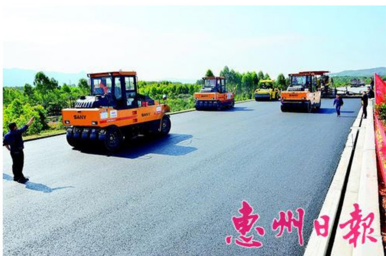
潮惠高速惠州段正在施工。 本报记者戴建 通讯员林晓青 摄
