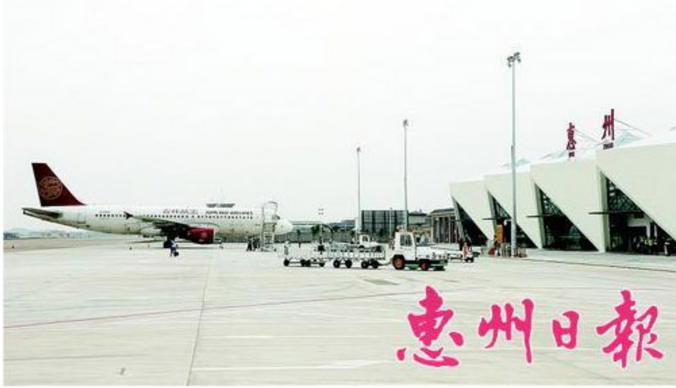
惠州机场通关快捷服务到位，打造广东“最快捷机场”。
